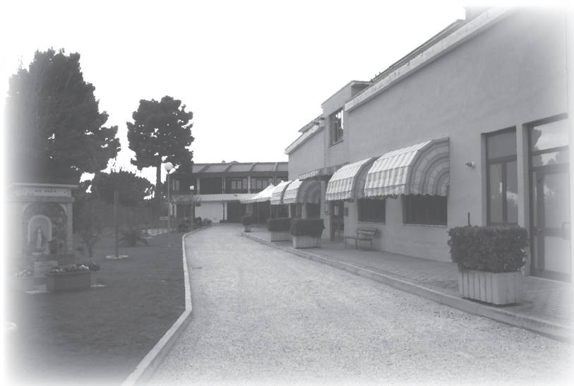
Esterno del Centro Sociale
